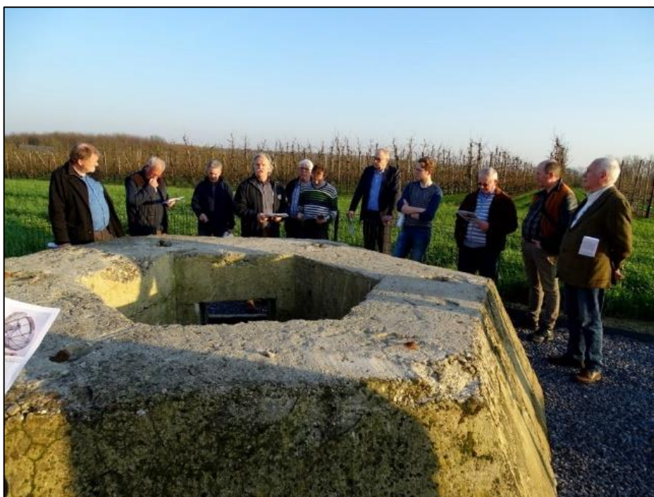
De betonnen fundering van de 'Würzburg-Riese' Radar
